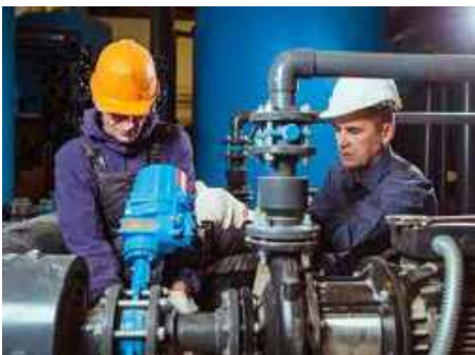
Монтаж, шеф-монтаж и пуско-наладочные работы
