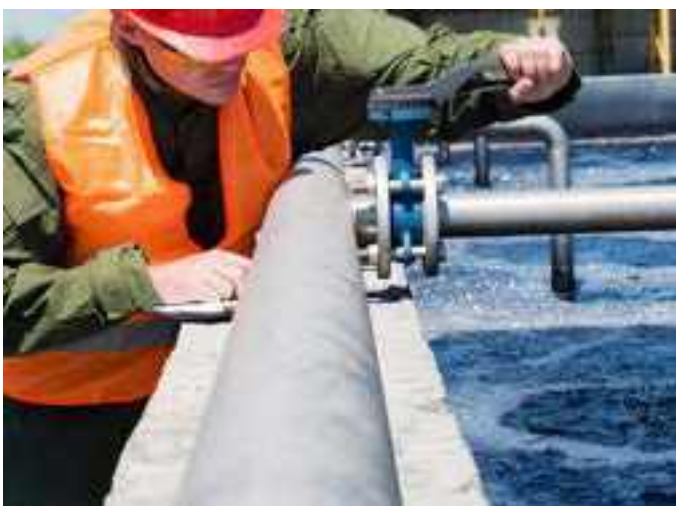
Комплексное обследование и аудит очистных сооружений
