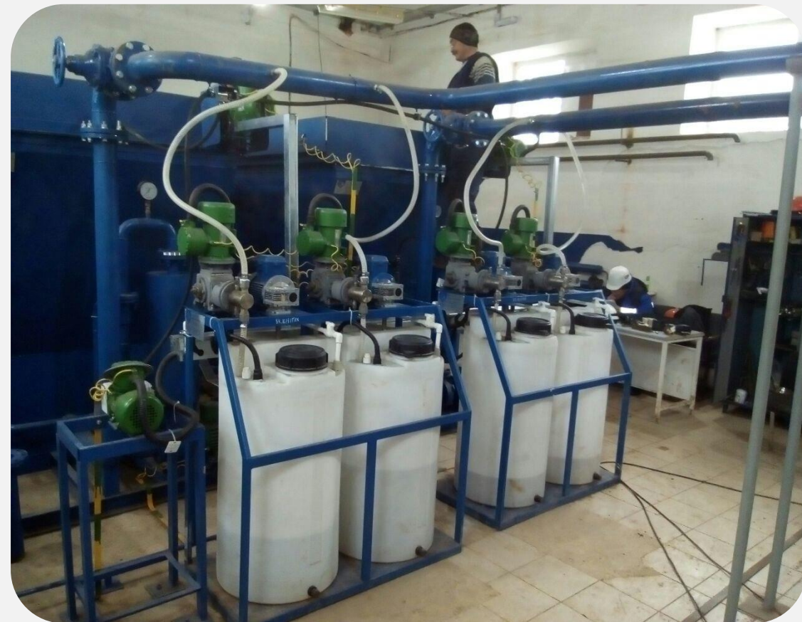
Станция очистки промливневых очистных сооружений. Заказчик: АО «Транснефть-Прикамье» ЛДПС Лазарево. Производительность 3 м 3 /час
