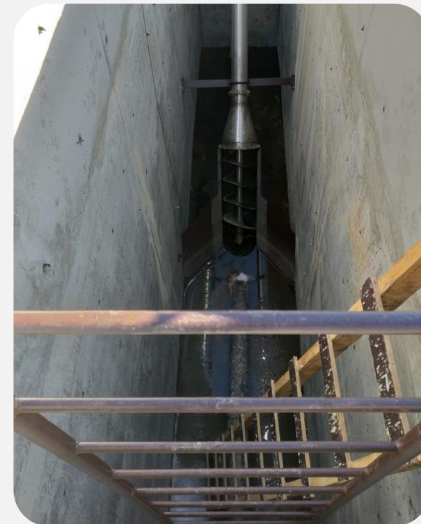
Шнековая решетка BAYKAL Заказчик: АО ДК «Антей» Республика Татарстан Производительность 120 м3/час.
