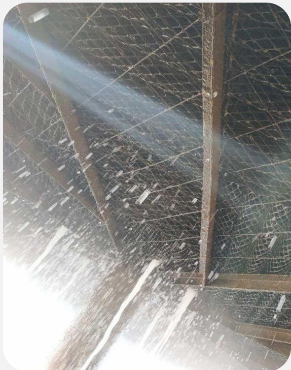
Блоки Оросителя БО-65Н Заказчик: ООО "Нива" Самарская область Габариты 1000x500x500мм
